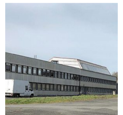
L'un des bâtiments en voie d'acquisition, par un investisseur vendéen, dans la zone industrielle de Saint-Porchaire.
